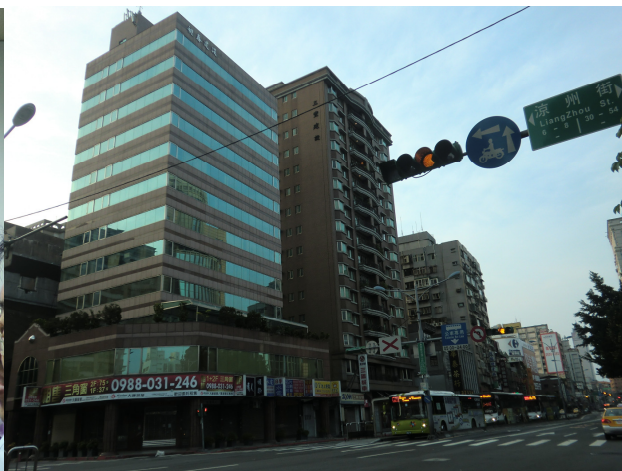
圖、新會址大樓外觀，位於重慶北路二段與涼州街口。
